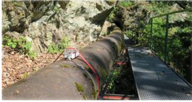
Fig. 2: Les Moulins penstock.
